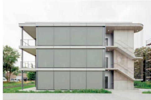
Bürogebäude TINA, Architekten - Studio Sozia © Kim Fohmann
