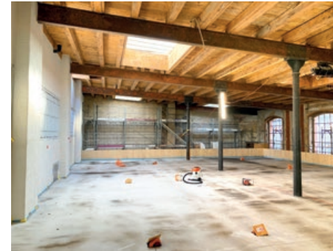
Umnutzung Tramdepot – Umbau Eicher Architekten © Esther Baur
