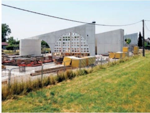
Chantier – juin 2023 ©N01 architecture
