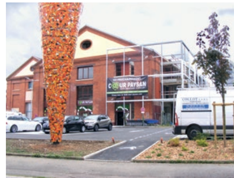
Vue du chantier de la fabrique côté rue de Bâle ©Ville de Mulhouse
