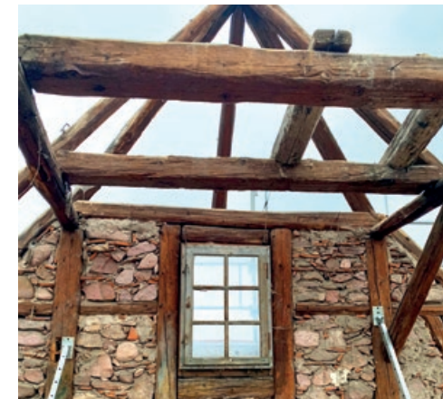
Travaux en cours en mars 2023 © Christophe Hurst
