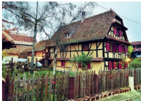
Façade après les travaux ©Loïc Cavalier
