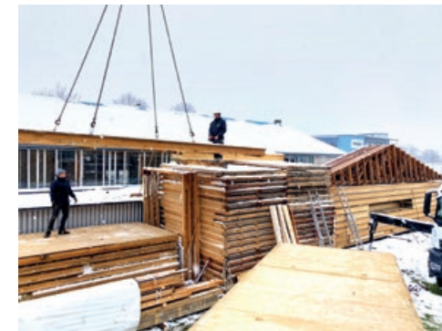
Déchargement des éléments de structure ©atelier bleu
