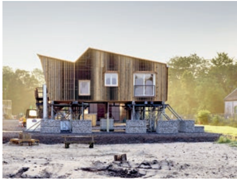
Gebäudeprototyp RoofKIT © Zoëy Braun
